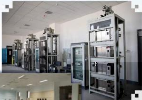
智能电梯安装调试 维护训练场所
